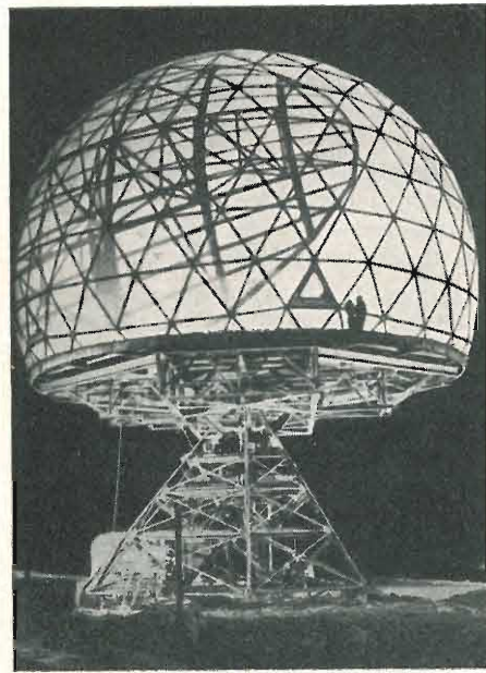
Somigliante ad una enorme lanterna giapponese, questa cupola-radar geodesica, montata sulla sommità di una torre-radar, serve a contenere il riflettore facente parte di un impianto radar a molti canali, di grande potenza costruito dalla GENERAL ELECTRIC COMPANY (USA). La torre, nota come « parte fissa di prova per antenna radar », fu eretta recentemente per consentire agli ingegneri della G. E. di determinare il grado di influenza di una cupola-radar sul ricevitore in essa contenuto. Sebbene essa pesi 60 tonnellate e debba essere in grado di far fronte a dei venti con velocità fino a 80 miglia orarie (150 km/ora), detto « sostegno » è in effetti uno strumento di precisione, per il funzionamento del quale sono ammesse solo lievissime tolleranze. (Da notare le dimensioni di un uomo, rispetto alla torre, al centro-destra della foto). (Foto Ipra)
